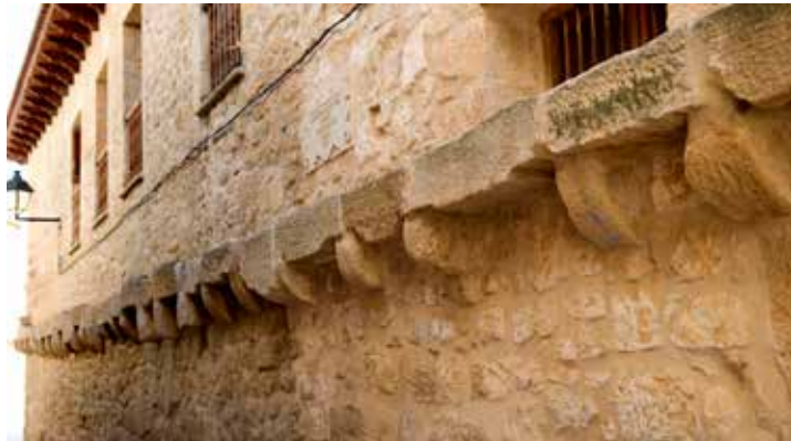
Fig. 24: Canal de piedra adosado a la fachada lateral del antiguo Molí de la Vila de Cretas.
