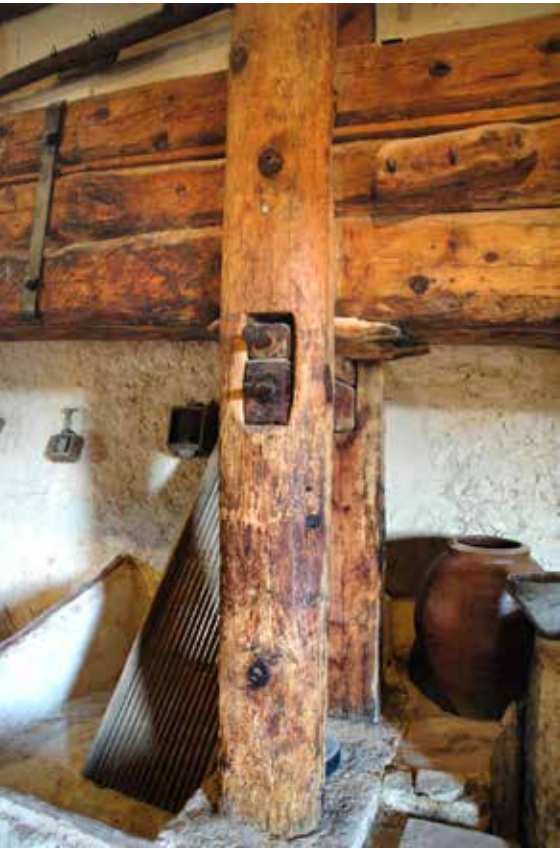
Fig. 21: Detalle de las guiaderas y la mediana o lavija doble que sostenía la prensa de viga o libra de la almazara de Jaganta, en las Parras de Castellote. Algunos lugares muy próximos al emplazamiento de este molino de aceite, como las poblaciones cercanas a la depresión del río Bergantes (Aguaviva, Mas de las Matas o La Ginebrosa) se especializaron en producir otros artículos como la seda o el vino. Foto: Alberto Bayod.
