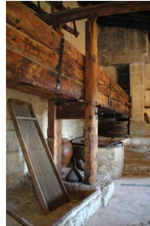
Fig. 26: Detalle de la zona más cercana a la presión que se ejercía sobre el pie en la almazara de Jaganta, pudiéndose apreciar las guiaderas y la mediana o lavija doble que sostenía la prensa de viga, la capilla de piedra donde se encajaba ésta y la pila que recogía el aceite que manaba tras la presión. Durante los últimos años del siglo XVI se produjo un fuerte incremento de los precios del oro líquido cuya oscilación llamó la atención de los propios coetáneos de la época. Foto: Alberto Bayod.
