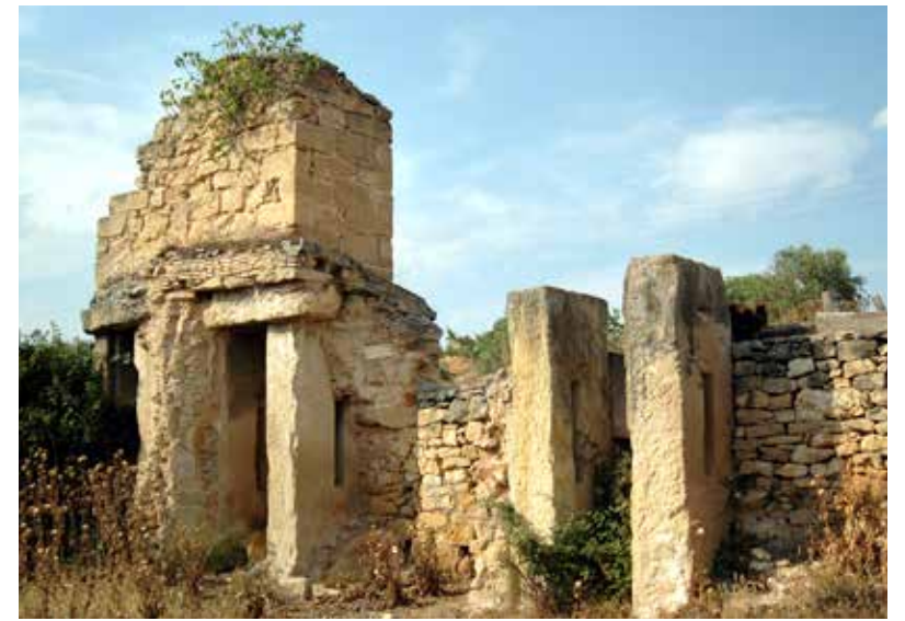
Fig. 4: Restos de tres de las seis capillas del antiguo molino de aceite comunal de La Codoñera, con sus piernas o contrapiernas de piedra y el torreón que servía de contrapeso a la fuerza que ejercían las vigas, realizado mediante sillares. Foto: Alberto Bayod.
