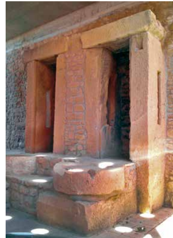
Fig. 18: Capillas de dos de las quince prensas del molino aceitero de Calaceite, con sus vírgenes de piedra y las ranuras para colocar las espadillas de madera. En 1747 se tomó una decisión crucial para el futuro del edificio, optando por continuar con su ampliación frente a la construcción de un molino nuevo que apuntaban algunos vecinos. Fue por entonces cuando se pasó de siete a diez prensas de viga. Foto: Alberto Bayod.
