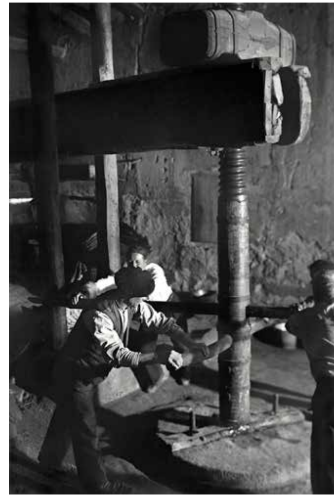
Fig. 32: Cuatro de los operarios del molino oleario de Piracés (Huesca) haciendo girar la caracola que activaba el funcionamiento de la prensa de viga (c. 1920-1936). Pese a la notable labor desarrollada por estas antiguas prensas y a su constante proliferación, a lo largo de las primeras décadas del siglo XIX se pusieron en marcha, en el Bajo Aragón, numerosas almazaras particulares que fueron complementando progresivamente el trabajo realizado en los molinos de aceite comunales hasta que se efectuó la desamortización y venta de los mismos. Foto: Ricardo Compañé Escartín. Fototeca de la Diputación de Huesca.
