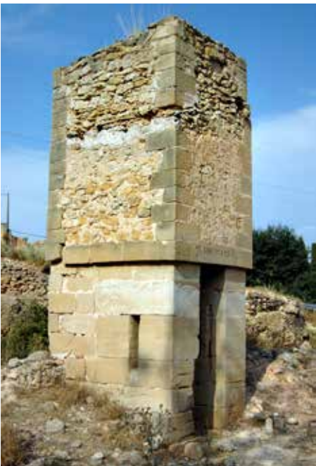
Fig. 8: Restos de una capilla para encajar la prensa de uno de los molinos de aceite de Torrecilla, con sus piernas de sillares y el torrejón que servía de contrapeso a la fuerza que ejercía la viga. Foto: Alberto Bayod.
