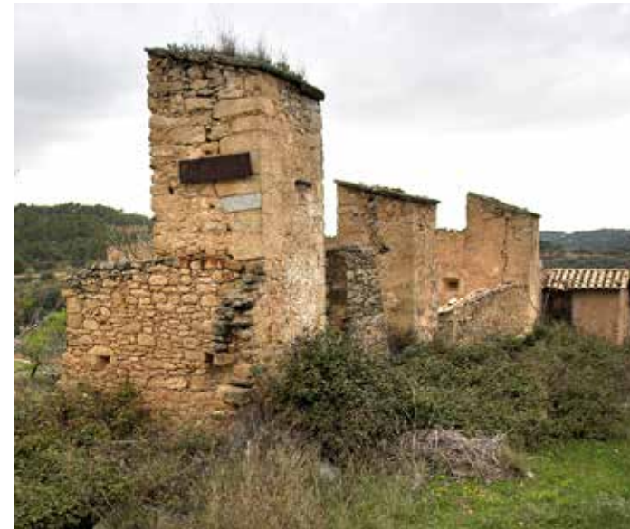
Fig. 12: Restos de la antigua almazara comunal de la población de Fórnoles, situada junto a la balsa de la localidad. En la imagen todavía pueden apreciarse los tres torrejones que servían de contrapeso a las capillas de las tres prensas de viga con las que contaba en el siglo XVIII. Foto: Blog Contalles de Fórnoles de Pedro J. Bel Caldú.
